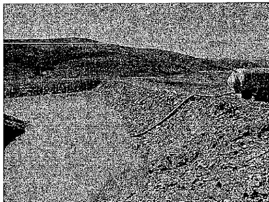
Fotos 1 y 2: Balsa provisional de recogida de escorrentías
